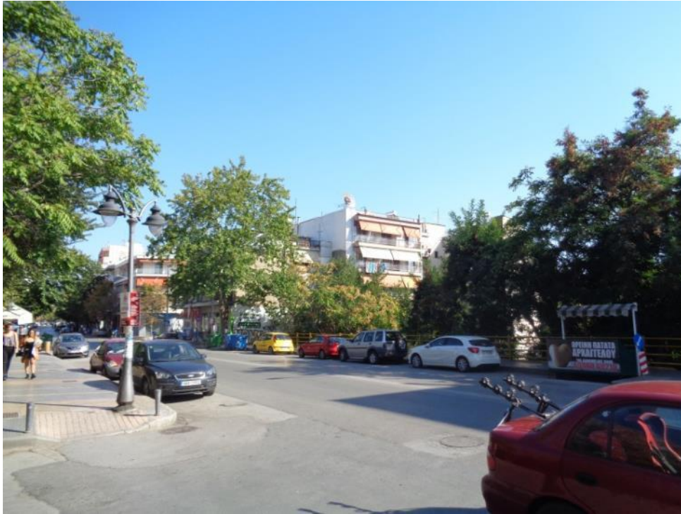
Εικόνα 12: Η γέφυρα της οδού Γ. Λαμπράκη.
