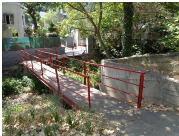
Εικόνα 37: Η πεζογέφυρα στην προέκταση της οδού Γ. Τζοβαρόπουλου.
