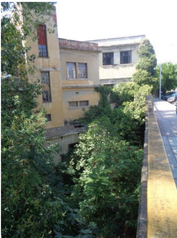
Εικόνα 60: Αποψη του Κτιριακού Συγκροτήματος της Υφανέτ και της πυκνής βλάστησης του ρέματος από την οδό Παπάφη.
