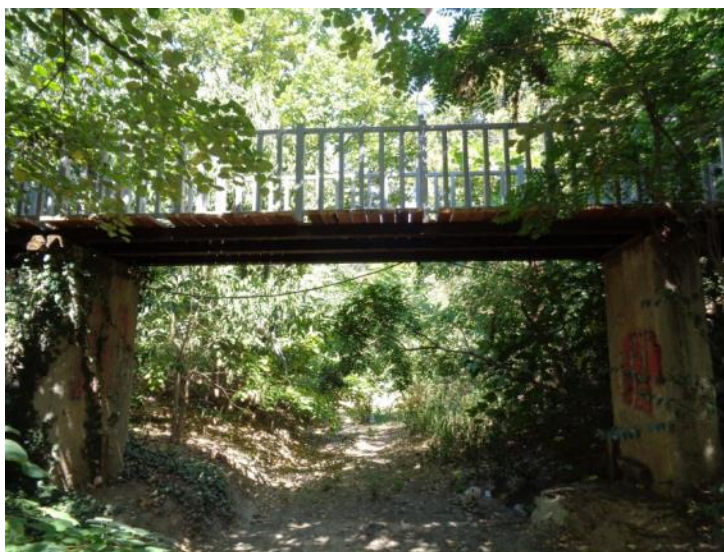
Εικόνα 16: Η πεζογέφυρα της οδού Γ. Πραΐδη.
