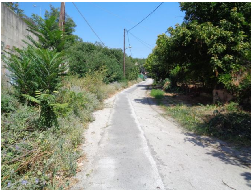
Εικόνα 55: Άποψη της οδού Κ. Ελευθεριάδου (ή Μίγγα) και του υποστηρικτικού τοιχίου της οδού Κατσιμίδα.
