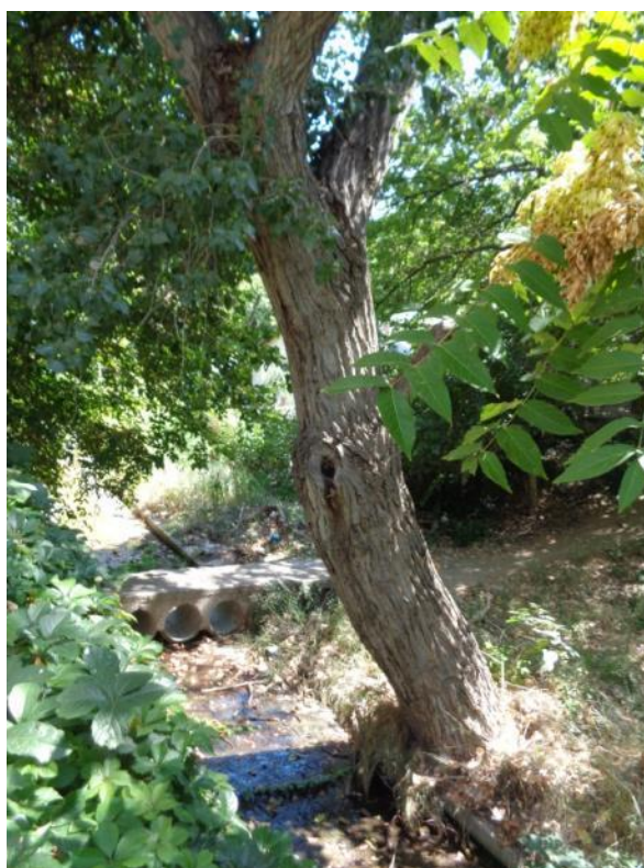
Εικόνα 56: Η πεζογέφυρα στο ύψος της κοίτης του ρέματος Δόξης.
