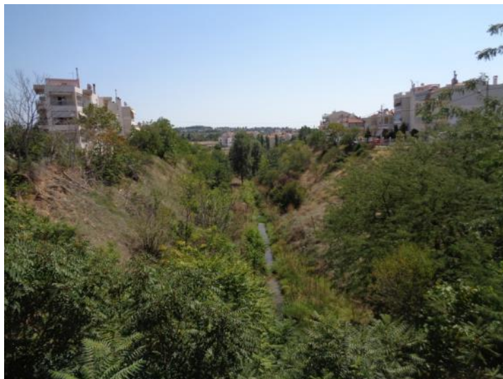
Εικόνα 19: Άποψη της Περιφερειακής Τάφρου προς τα κατάντη από τη γέφυρα της οδού Βεργίνας.
