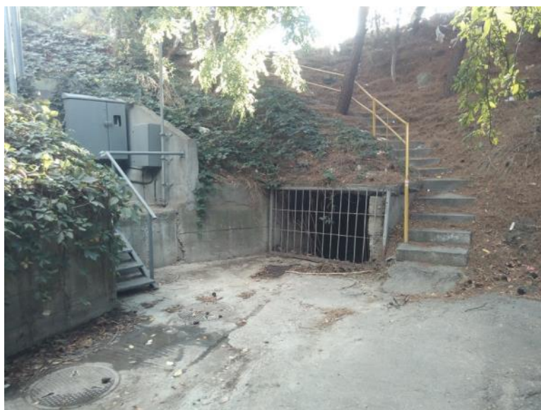
Εικόνα 36: Η απόληξη της οδού Κ. Ελευθεριάδου και το φρεάτιο φόρτισης.
