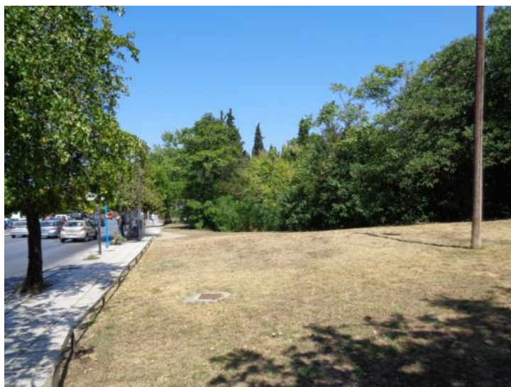
Εικόνα 38: Το σημείο υπογειοποίησης του ρέματος στην οδό Νέας Εγνατίας.
