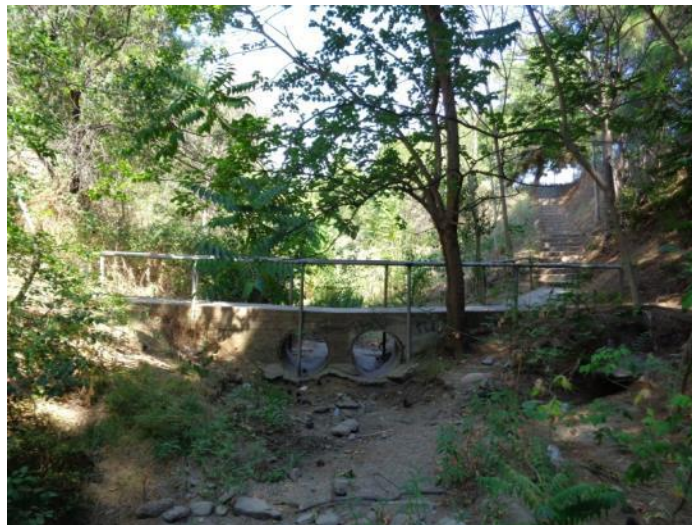
Εικόνα 15: Η διάβαση της οδού Χ. Περραιβού στο ύψος της κοίτης της Τάφρου.
